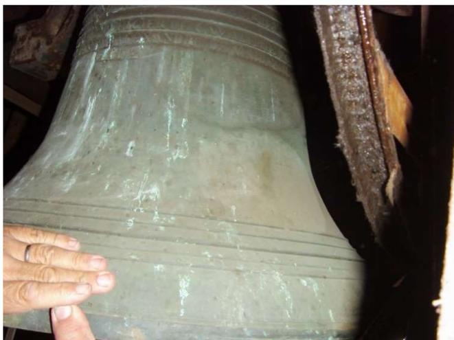
Après la visite d'entretien du mécanisme de fonctionnement électrique des cloches, les Ets Bodet nous ont prévenu que les battants, en mauvais état, devaient être remplacés.
